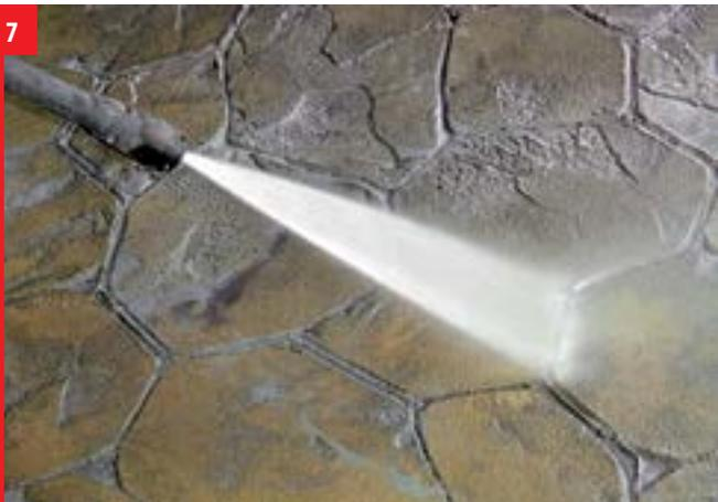
Смывание разделителя водой под давлением с поверхности застывшего бетона.
