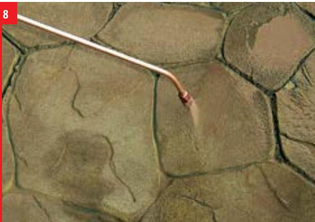
Пропитка сухой поверхности с помощью распыления акрилового препарата BAUSEAL ENDURO PLUS придающей интенсивный цвет и ограничивающей проникновение воды, масел, смазочных материалов и тп.
