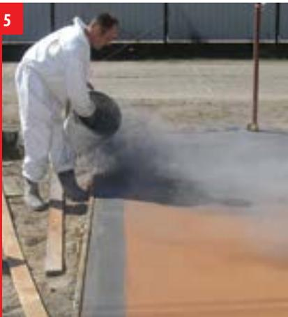
Нанесение слоя разделителя PRESSBETON предотвращающего приклеивание форм к поверхности бетона.
