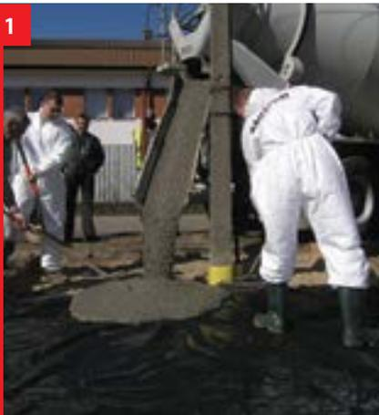
Укладка композитного бетона на соответствующе подготовленное основание.
