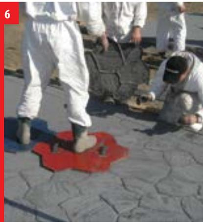
Штамповка узоров на поверхности свежего бетона с помощью специальных форм.
