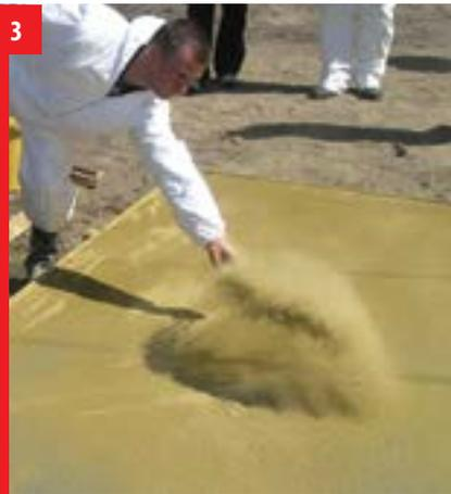
Нанесение соответствующего количества цветного отвердителя MULTITOP PRESSBETON на поверхность свежего бетона.
