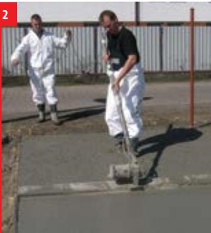
Уплотнение бетона плавающей виброционной рейкой
