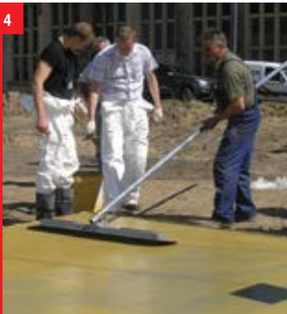
Втирание и разглаживание нанесенного отвердителя с помощью специальной стальной терки.
