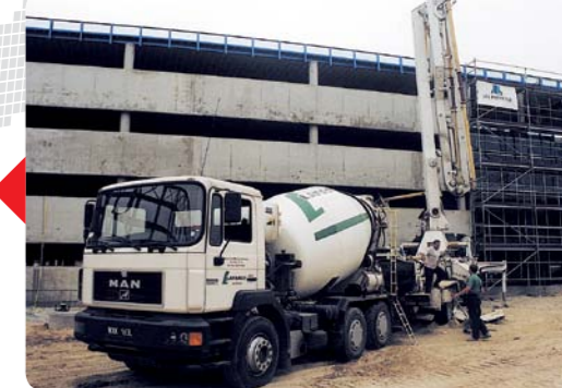
Pompowanie mieszanki betonowej.
