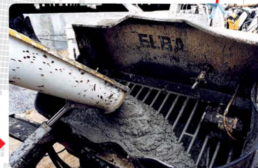
Pompowanie mieszanki betonowej.
