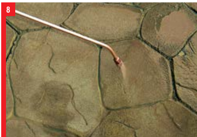
8 Impregnowanie suchej nawierzchni natryskiem akrylowego preparatu BAUSEAL ENDURO PLUS nadające jej intensywny kolor i ograniczające penetrację wody, olejów, smarów itp.
