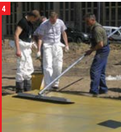
4 Wtarcie i wygładzenie naniesionego utwardzacza przy pomocy specjalnej pacy stalowej.
