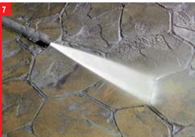
7 Zmywanie rozdzielnika agregatem ciśnieniowym z powierzchni związanego betonu.
