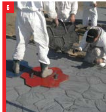
6 Odciskanie wzoru na powierzchni świeżego betonu przy pomocy odpowiednich form.
