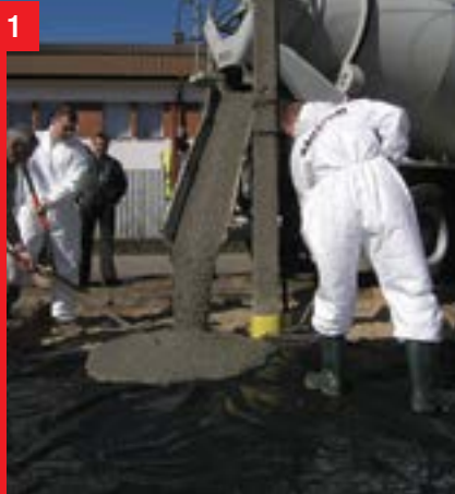
1 Rozkładanie betonu kompozytowego na odpowiednio przygotowanej podbudowie.
