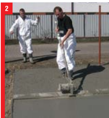
2 Zagęszczenie rozłożonego betonu płytującą listwą wibracyjną.
