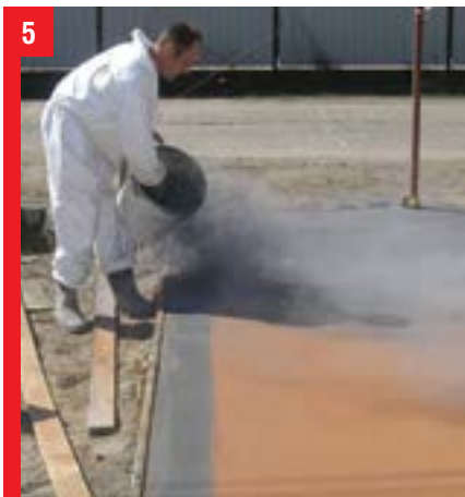
5 Nanoszenie warstwy rozdzielnika PRESSBETON zapobiegającego przywieraniu form odciskowych do powierzchni betonu.
